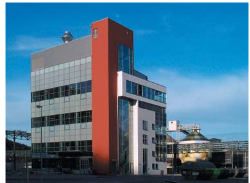
GMP-Chemie-Anlage degussa: 3000 m 2 + 20.000 m 3
